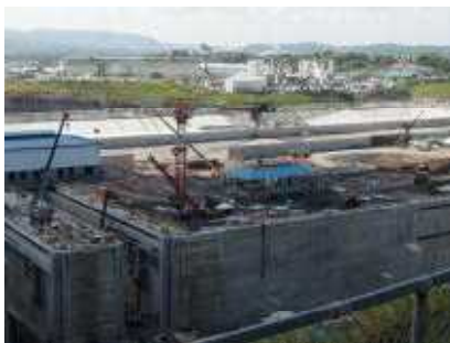
パナマ運河拡張建設現場
